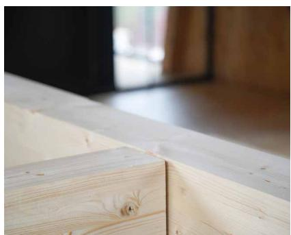
Pre správnu montáž spoja odporúčame pred vložením konektorov najskôr utiahnúť jednotlivé prvky.
