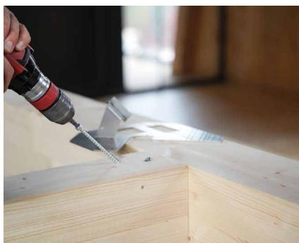
Po zaskrutkovaní približne tretiny skrutky odložte šablónu JIGVGZ45 a pokračujte v montáži.
