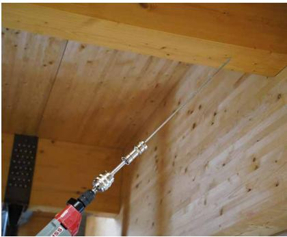
Vďaka pomôcke CATCH bude možné rýchlo a bezpečne zaskrutkovať aj dlhšie skrutky, bez rizika zošmyknutia bitu. Kompatibilné s TORQUE LIMITER.
