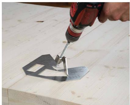
Pre zaručenie správneho umiestnenia a sklonu skrutiek VGZ odporúčame použiť šablónu JIGVGZ45 naklonenú pod 45° uhlovom k hľave panelu.
