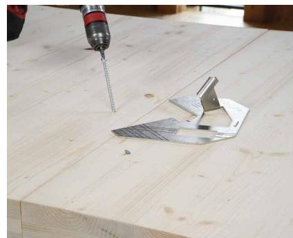
Rovnaký postup zopakujte pri montáži skrutky vloženej do vedľajšieho panelu a pokračujte striedavým spôsobom podľa vzdialostí uvedených v projekte.
