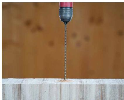
Predvŕtajte otvor požadovaného priemeru ( $d_{V,H}$ ) a dĺžky v závislosti od rozmeru vybraného konektora pomocou hrotu SNAIL.
