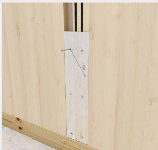
Fixação de painéis de isolamento de paredes com THERMOWASHER e HBS de 8 mm de diâmetro.
