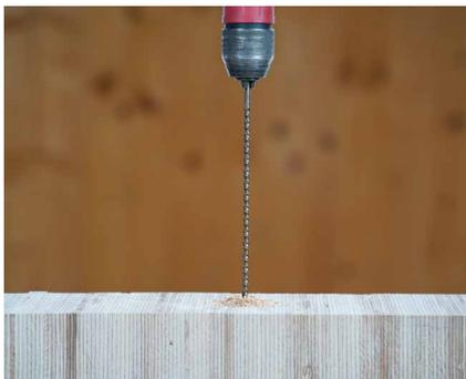
Efetuar um furo com o diâmetro necessário ( $d_{V,H}$ ) e o comprimento igual ao tamanho do conector escolhido, utilizando a ponta SNAIL.
