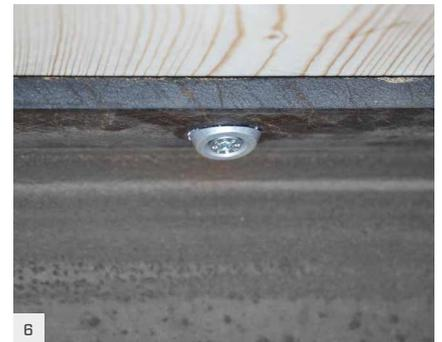
6 Instalação concluída. A inclinação do parafuso a 15° garante que a distância até à cabeça do painel (ou viga) é mantida.
