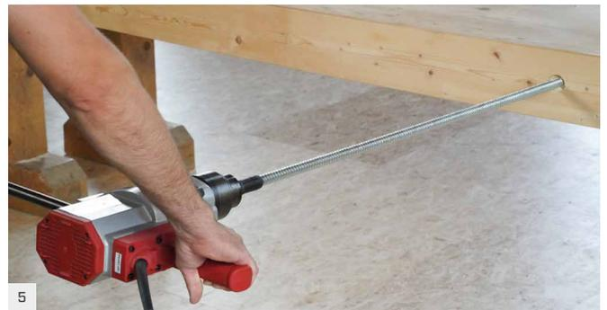
Inserir a manga na varão rosçado e o adaptador na aparafusadora. Recomenda-se a utilização da pega (DUD38SH) para garantir maior controlo e estabilidade durante o aparafusamento.
