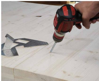
Depois de apertar cerca de um terço do parafuso, remover o gabarito JIGVGZ45 e continuar com a instalação.
