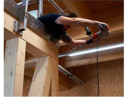
Útil no caso de aparafusamento em cantos, que normalmente não permitem exercer muita força de aparafusamento.
