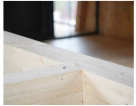
O parafuso HBS eliminou a distância presente inicialmente entre os elementos. Depois de posicionar os conectores VGZ, pode ser removido.
