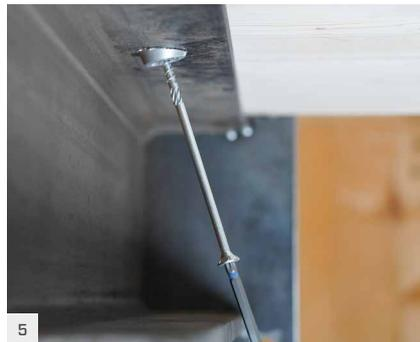
5 Instalar o parafuso HBS com o comprimento desejado. Não utilizar aparafusadoras de impacto. Prestar atenção na fase de aperto da junta.
