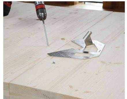
Repetir o procedimento para instalar o parafuso inserido no painel adjacente e continuar esta sequência alternada de acordo com as distâncias previstas no projeto.
