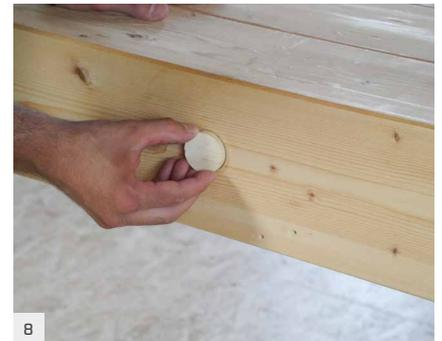
Se previsto, inserir uma tampa TAP para ocultar a varão rosçado e garantir um melhor acabamento estético e resistência ao fogo.
