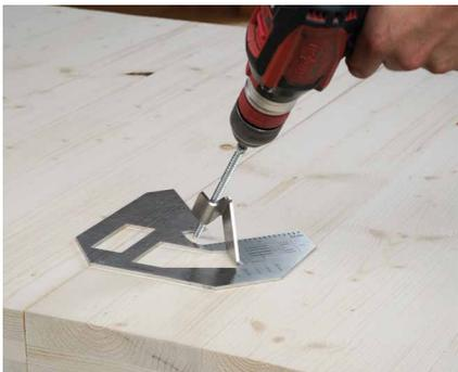
Para garantir o posicionamento e a inclinação corretos dos parafusos VGZ, recomenda-se a utilização do gabarito JIGVGZ45 posicionado a 45° em relação à cabeça do painel.
