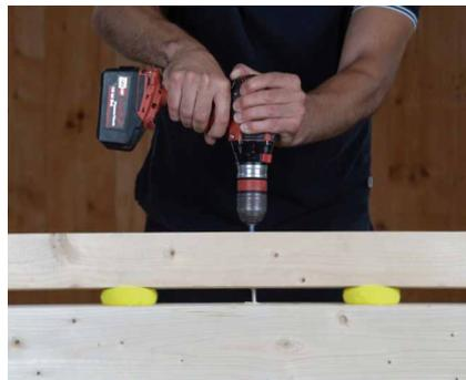
O parafuso de rosca parcial (por ex. HBS) permite fechar a junta. A parte roscada, inserida totalmente no interior do segundo elemento, permite que o primeiro elemento deslize na haste lisa.
