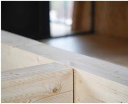
Para uma instalação correta da junta, recomenda-se que os elementos sejam apertados antes de inserir os conectores.
