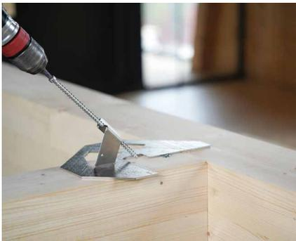
Para garantir o posicionamento e a inclinação corretos dos parafusos VGZ, recomenda-se a utilização do gabarito JIGVGZ45.
