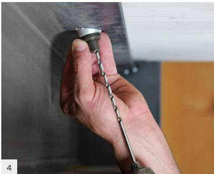
4 Fazer um furo de guia com um diâmetro de 5 mm e um comprimento mínimo de 20 mm, de preferência utilizando o gabarito JIGV945 para assegurar a direção de instalação correta.
