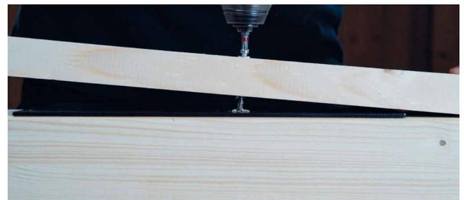
Um furo aumentado evita que o elemento de madeira se levante do metal de base durante a perfuração do metal.
