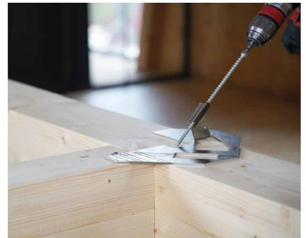
Repetir o procedimento para instalar o parafuso inserido da viga principal na secundária.
