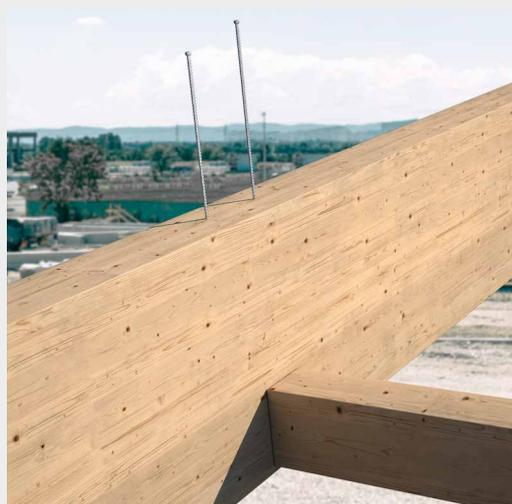
Assemblage à rigidité très élevée de planchers accouplés en CLT.
