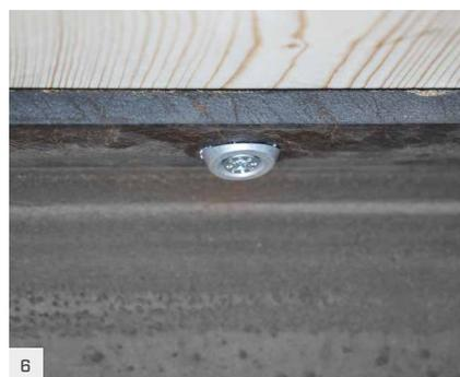
L'installation est terminée. L'inclinaison à 15° de la vis permet de respecter la distance par rapport à la tête du panneau (ou de la poutre).
