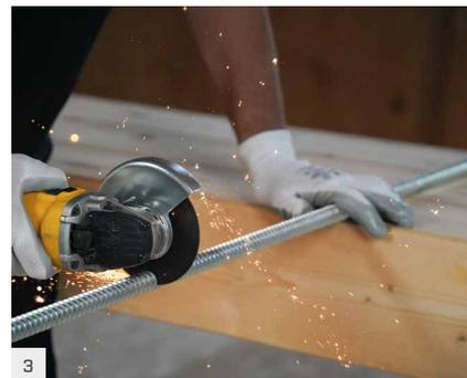
3 Couper la tige filetée RTR à la longueur souhaitée, en veillant à ce qu'elle soit inférieure à la profondeur du pré-perçage.
