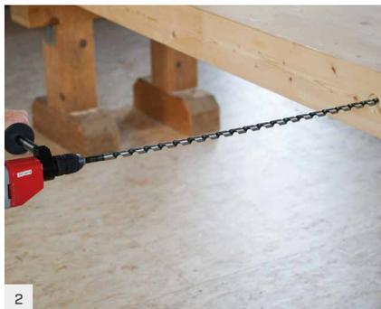
2 Effectuer le pré-perçage à l'intérieur de l'élément en bois en s'assurant qu'il soit rectiligne. L'utilisation du COLUMN assure une meilleure précision.
