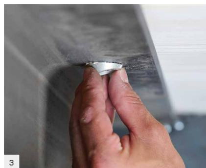
Retirer le liner et appliquer la rondelle au niveau du trou, en faisant attention au sens d'insertion.
