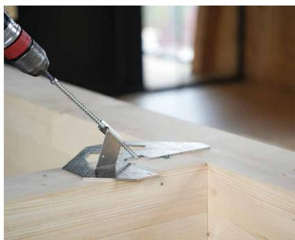
Pour garantir le bon positionnement et l'inclinaison correcte des vis VGZ, nous conseillons d'utiliser le gabarit JIGVGZ45.
