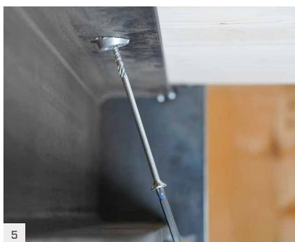
Installer la vis HBS de la longueur souhaitée. Ne pas utiliser de visseuses à impulsions. Attention au serrage de la connexion.
