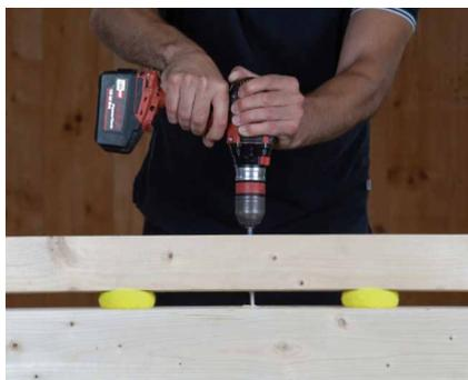
La vis à filetage partiel (par ex. HBS) permet de fermer l'assemblage. La partie filetée, entièrement insérée dans le second élément, permet au premier élément de glisser sur la tige lisse.
