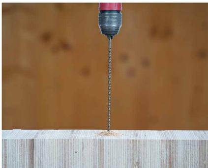
Effectuer un pré-perçage du diamètre requis ( $d_{V,H}$ ) et de la même longueur que le connecteur choisi à l'aide de la pointe SNAIL.
