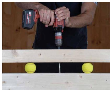
La vis à filetage total (par ex. VGZ) transmet la force en exploitant sa résistance axiale et pénètre à l'intérieur des éléments en bois sans que ceux-ci ne bougent.
