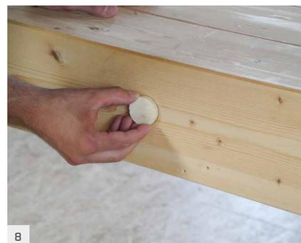
8 Si prévu, insérer un capuchon TAP pour dissimuler la tige filetée et assurer une meilleure finition esthétique et une meilleure résistance au feu.
