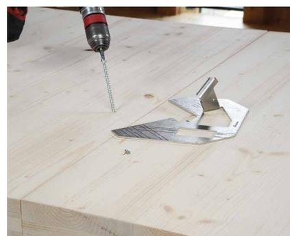
Répéter la procédure pour installer la vis insérée dans le panneau adjacent et continuer cette séquence alternée en fonction des distances prévues dans la conception.
