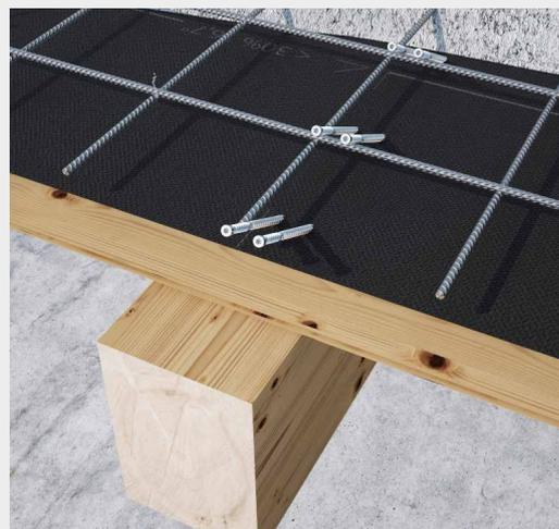
Plancher collaborant bois - béton avec disposition connecteurs à 30° sur double rangée.
