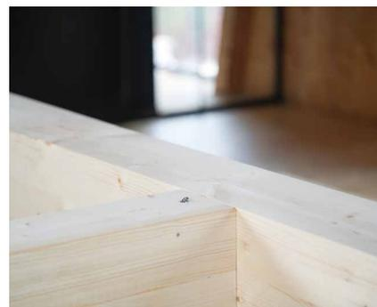
La vis HBS a éliminé l'espace initialement présent entre les éléments. Après avoir positionné les connecteurs VGZ, elle peut être retirée.
