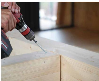
Insérer une vis à filetage partiel (ex. HBS680) pour rapprocher les éléments.
