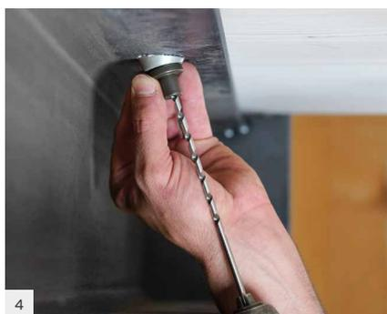
Percer un trou de guidage d'un diamètre de 5 mm et d'une longueur minimale de 20 mm, de préférence à l'aide du gabarit JIGV945 pour garantir le bon sens d'installation.
