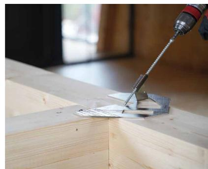
Répéter la procédure pour installer la vis insérée de la poutre principale à la poutre secondaire.
