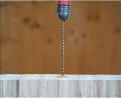
选用 SNAIL 钻头，预制一个所需直径 ( $d_{V,H}$ ) 且长度等于所选螺钉尺寸的孔。
