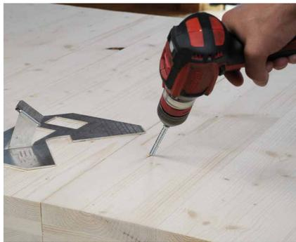
拧入大约三分之一的螺钉后，拆下 JIGVGZ45 模板并继续安装。
