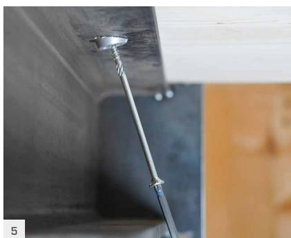
5 安装所需长度的 HBS 螺钉。请勿使用脉冲型电钻。注意接头处的紧固阶段。
