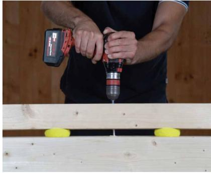
半螺纹螺钉（例如 HBS）能够闭合接头。螺纹完全插入第二构件内部，以便第一构件可在光滑螺杆上滑移。
