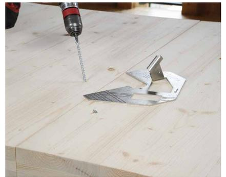
重复该过程以安装相邻面板的螺钉，并根据项目规定的距离继续此交替顺序。
