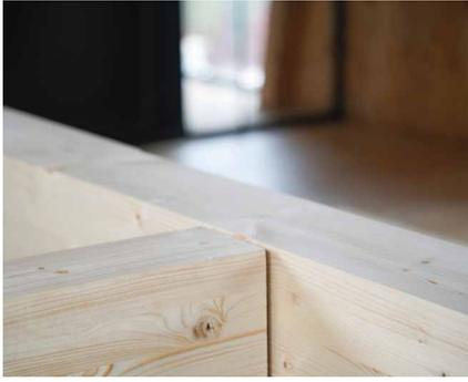
为了正确安装节点，建议在攻入螺钉之前锁定构件。
