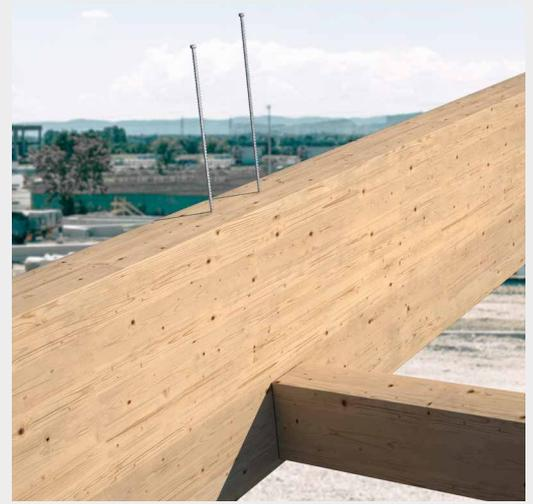
由于主次梁连接所致的悬挂荷载对纹理的正交加固。
