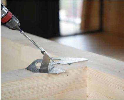
为确保 VGZ 螺钉的正确定位和倾斜度，建议使用 JIGVGZ45 模板。
