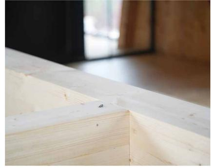
HBS 螺钉消除了构件之间的初始距离。放置 VGZ 螺钉后，即可将 HBS 螺钉移除。
