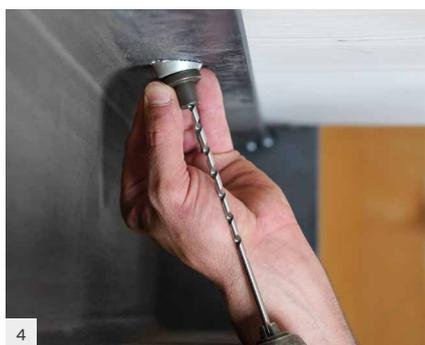
4 钻一个直径为 5 mm、最小长度为 20 mm 的导向孔，最好借助 JIGVGU945 模板，以确保正确的安装方向。
