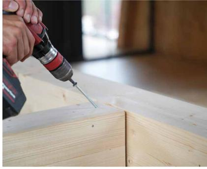
半螺纹螺钉 (例如 HBS680) 将构件组合在一起。
